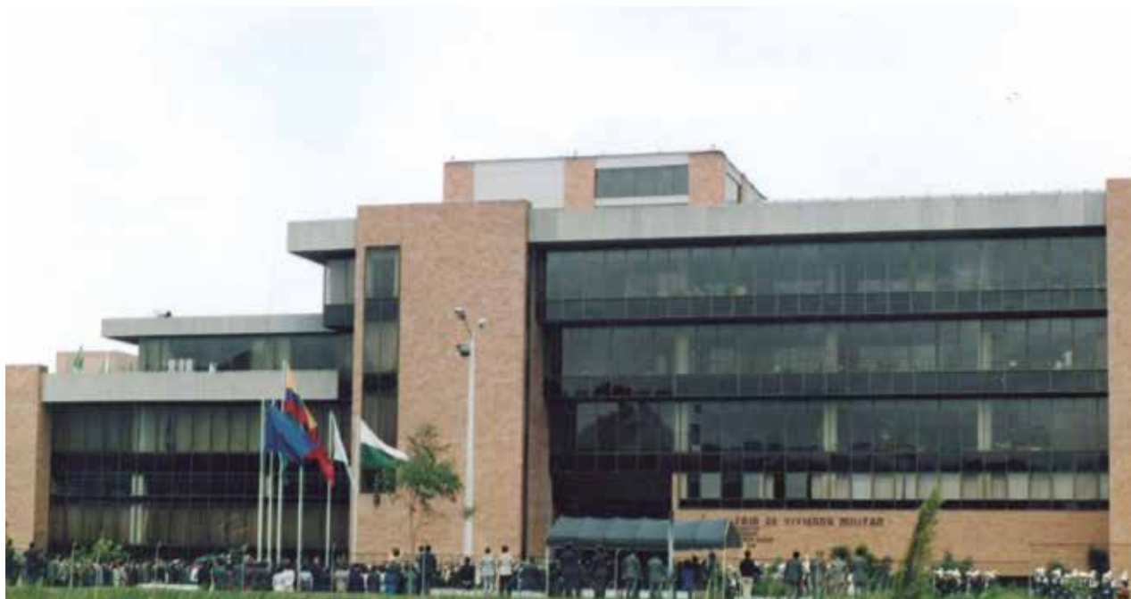
En octubre de 1986 culminó la construcción de la segunda sede propia ubicada en la carrera 54 con calle 26, Bogotá.
