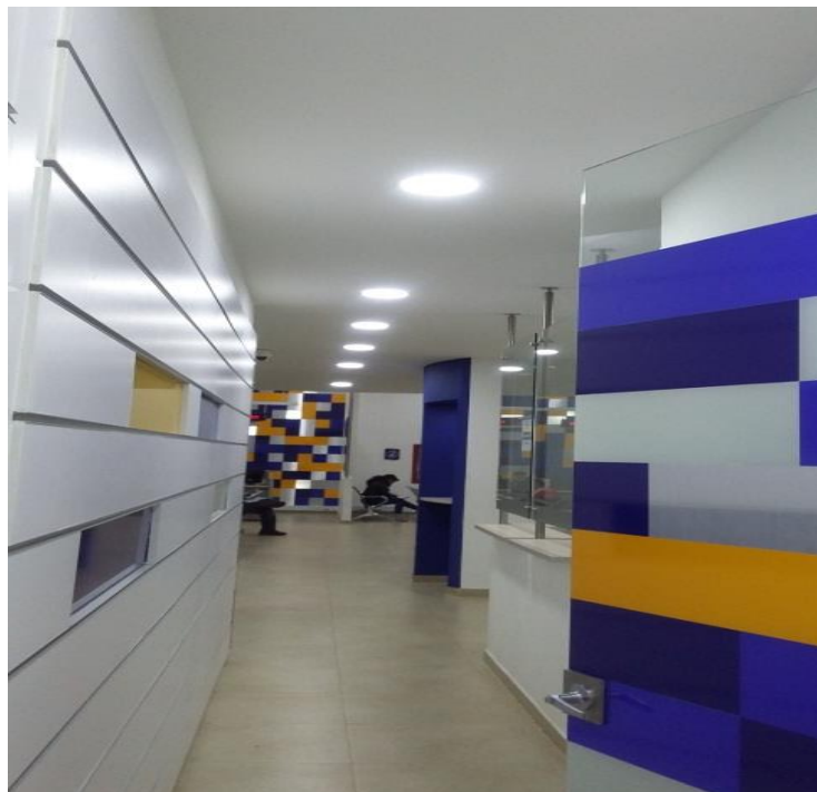
IMAGEN No. 8: Suministro e instalación de luminaria tipo led de 40 W
